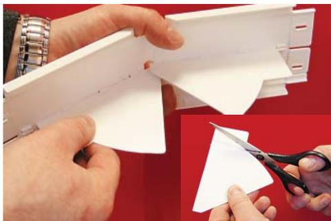
Вставьте разделители в направляющие на базе угла. Для углов менее 90° рекомендуется отрезать часть разделителя
