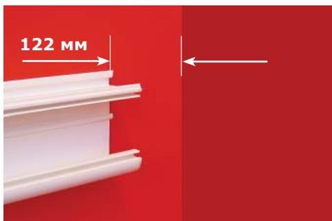
Закрепите кабель-канал на расстоянии 122 мм от угла стены (используйте базу угла как шаблон)
