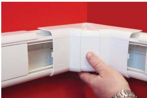
Установите накладку угла и крышки кабель-канала
