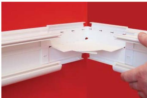
Вставьте в базу угла вторую часть кабель-канала и закрепите его на стене
