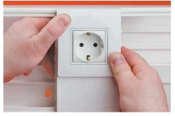
Защелкиванием установите декоративную рамку электроустановочного изделия. Защелкиванием установите крышки на короб
