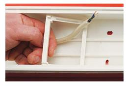
Разместите внутри короба фиксатор рамки (защелками наружу) и пропустите через него кабель. Потяните на себя фиксатор, и он защелкнется с внутренней стороны на короб
